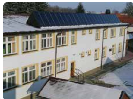
Přizvednutá Al konstrukce
