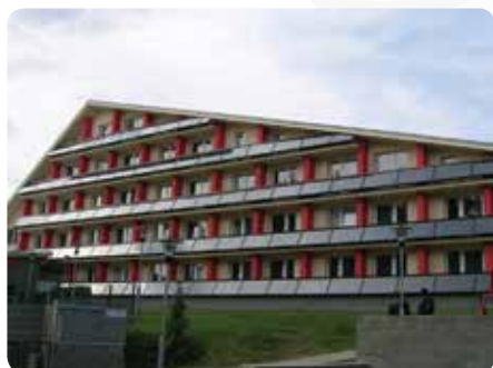
Kolektory na zábradlí
