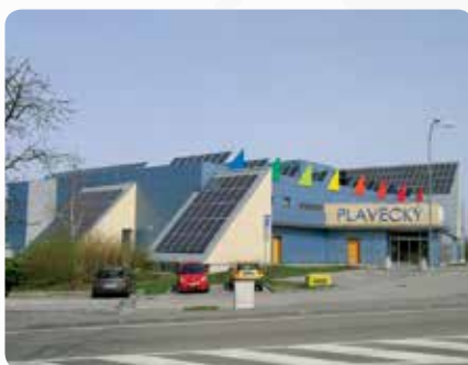
Aquapark v Jindřichově Hradci, 40 ks slunečních kolektorů.
