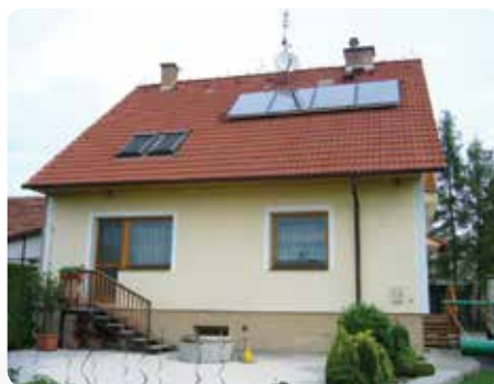
Systém ohřevu kombinované akumulční nádrže – RD Mohelno, 4 ks TS 500, aku nádrž PSWF 800.
