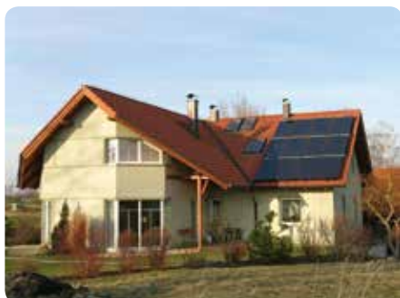
Kolektory nad střešní krytinou
