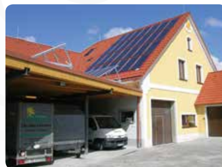
Sídlo firmy JH Solar, 28 ks slunečních kolektorů TS 400, solární topení.
