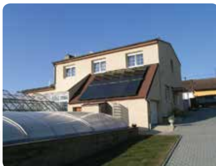
Kolektory nad střešní krytinou
