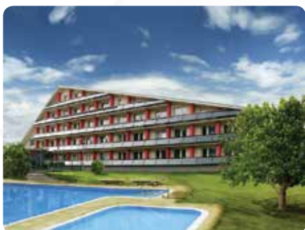
Hotel Jezerka, 80 + 42 ks slunečních kolektorů TS 330, ohřev teplé vody a bazénů.
